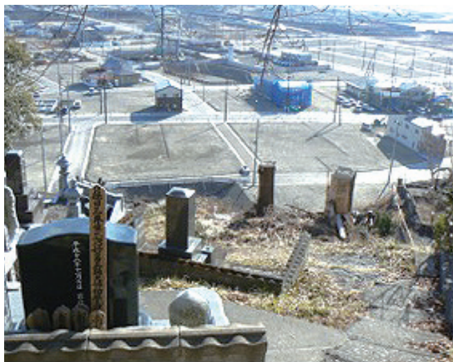
津波ですべて流された土地の盛り土工事、それを見守るご先祖の墓
